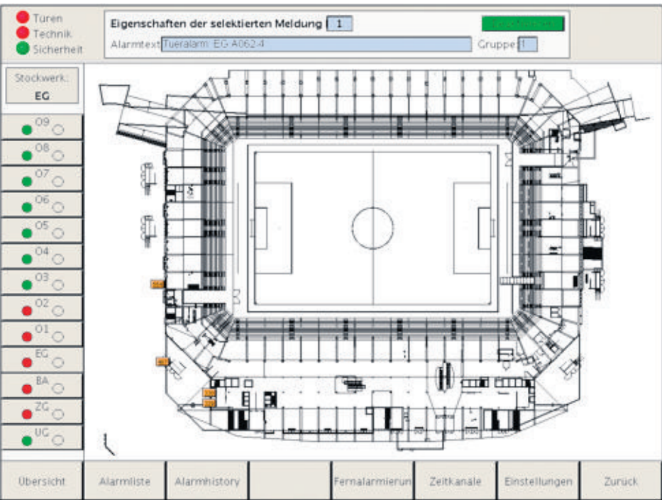
► Système de contrôle Voici l'un des panneaux de contrôle auxquels pouvait avoir accès un hacker, sans trop d'efforts. Il lui aurait ensuite été possible de désactiver des alarmes et même de déverrouiller certaines portes d'accès.
